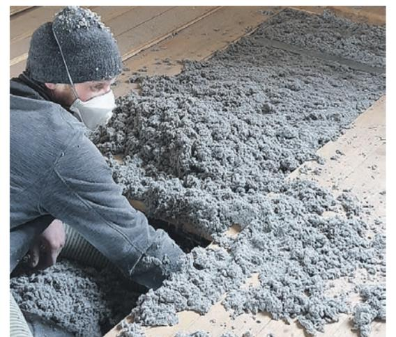
Die Fasern verfilzen beim Einblasen und füllen jeden noch so kleinen Hohlraum fugenlos aus.
